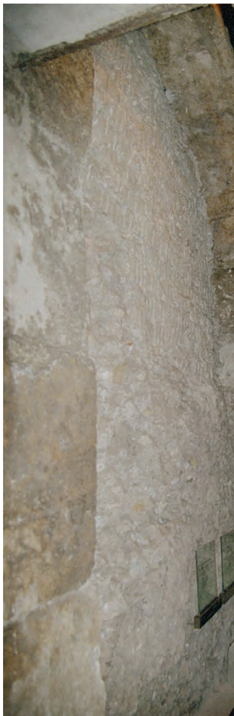
Abb. 9 Das zubetonierte Warren-Tor im Westmauer Tunnel
