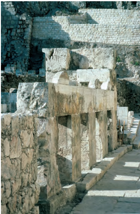
Abb. 6 Der mächtige Fuß des Robinson-Bogens. Rechts davon: Die originale Straße entlang der Westmauer des Tempelbezirks (Blick von Süden). Er wies in der Nord-Süd-Richtung eine Länge von 15,2 m auf. Seine Breite betrug 3,6 m. 41
